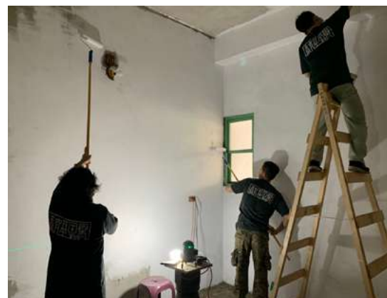
▲ 居家修繕 - 牆面粉刷。
