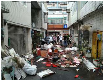
▲ 居家修繕 - 清除三大車廢棄物。
