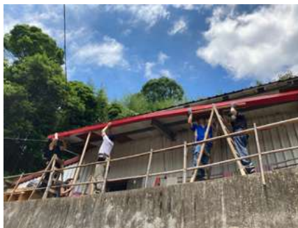
▲ 居家修繕 - 鐵皮屋雨溝更新。
