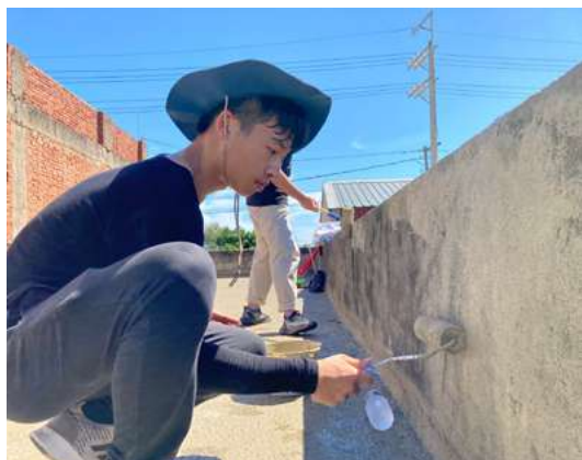
▲ 居家修繕 - 頂樓防水工程。
